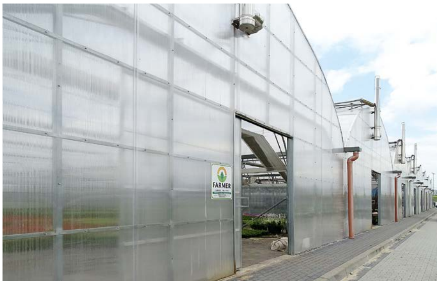
Fot. 10. Tunel zblokowany, który ma 8 naw i stawiany był sukcesywnie od 2009 do 2018 roku
