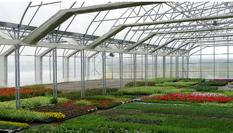
Fot. 11. Dwie najnowsze nawy bloku foliowego mają nietypową szerokość 11 m – pozwoliło to na maksymalne wykorzystanie powierzchni dostępnego terenu
