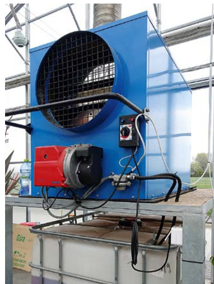
Fot. 12. Jeden z czterech pieców nadmuchiowych P-90 z firmy PPHU Ekopiec
